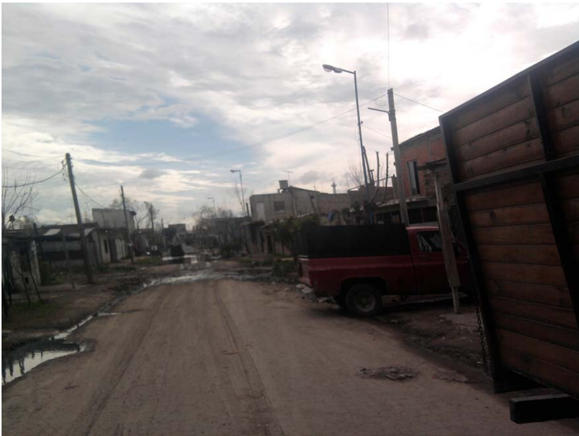
Calle León Suarez, en el mapa de obras del municipio dice estar asfaltado a nuevo, se ve en la foto totalmente destruido fecha 17/8/2010.
