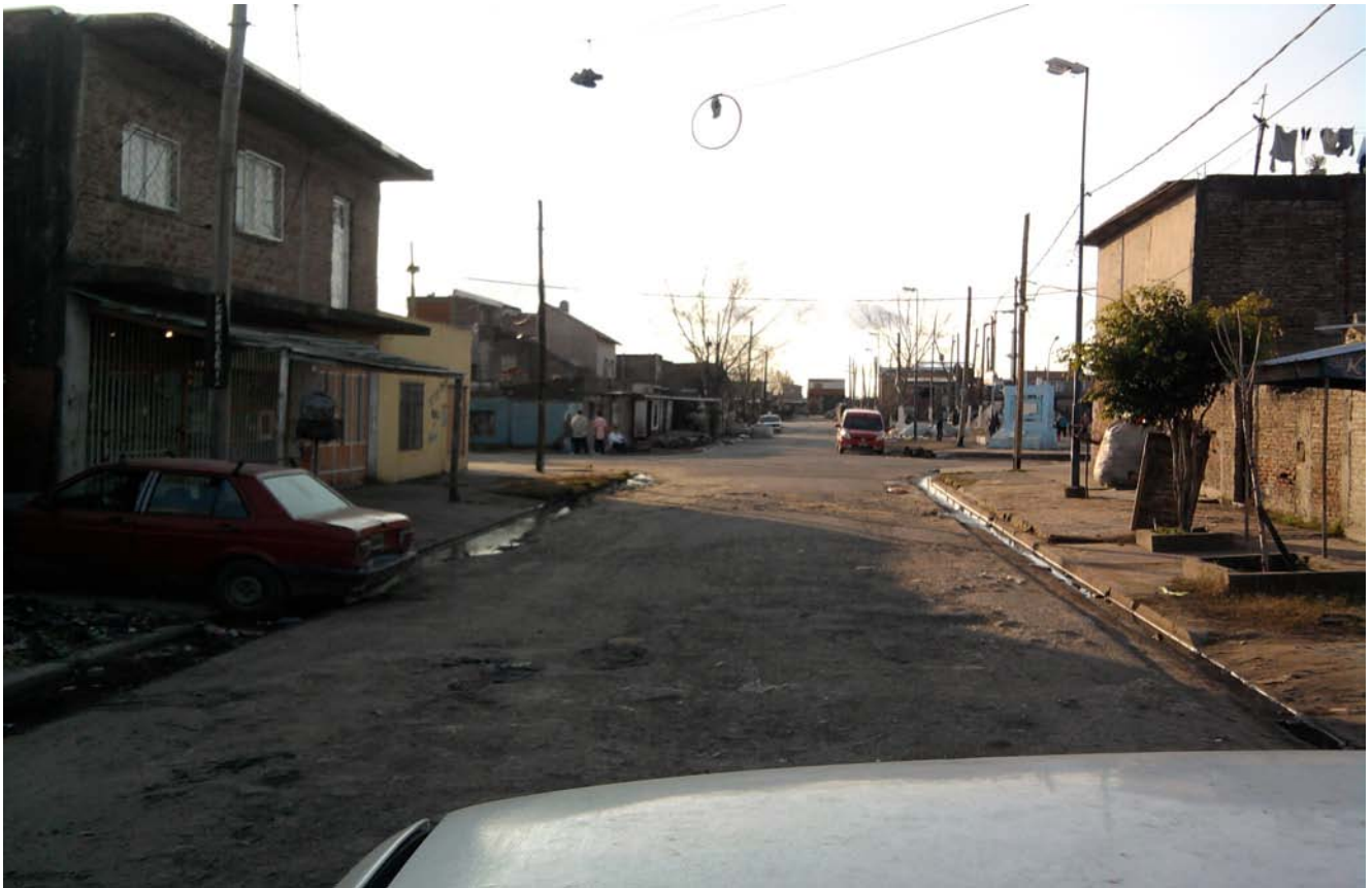
Calle Gral. Villegas y Balbin, asfalto totalmente destruido. Fecha 17/08/2010.
